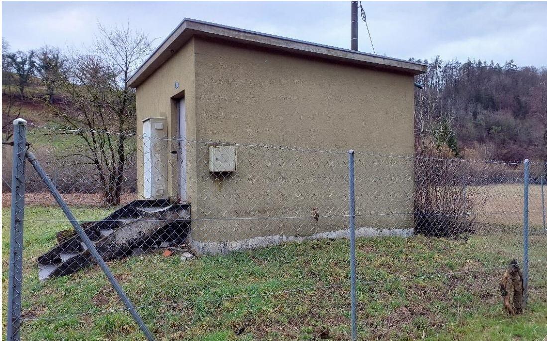
Abbildung 1: Das Grundwasserpumpwerk Oris.
