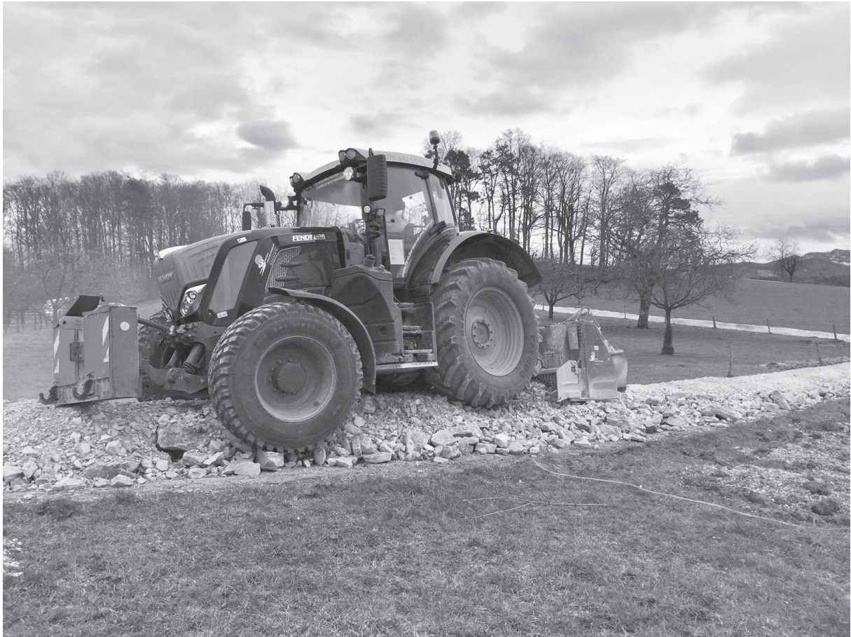
Foto: W. Schwander – Der Galmsweg wird saniert.
